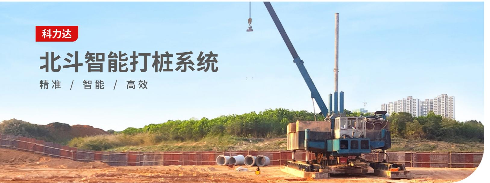
科力达北斗智能打桩系统是集高精度卫星定位技术、物联网技术、移动互联网技术、多功能传感器技术以及云计算技术等多项前沿技术于一体的智能系统。系统采用科力达高精度一体双天线模式接收基站的差分改正数据，以确定并解算前后天线坐标与姿态，并通过专业的打桩软件来实现打桩放样，提高打桩作业效率。
